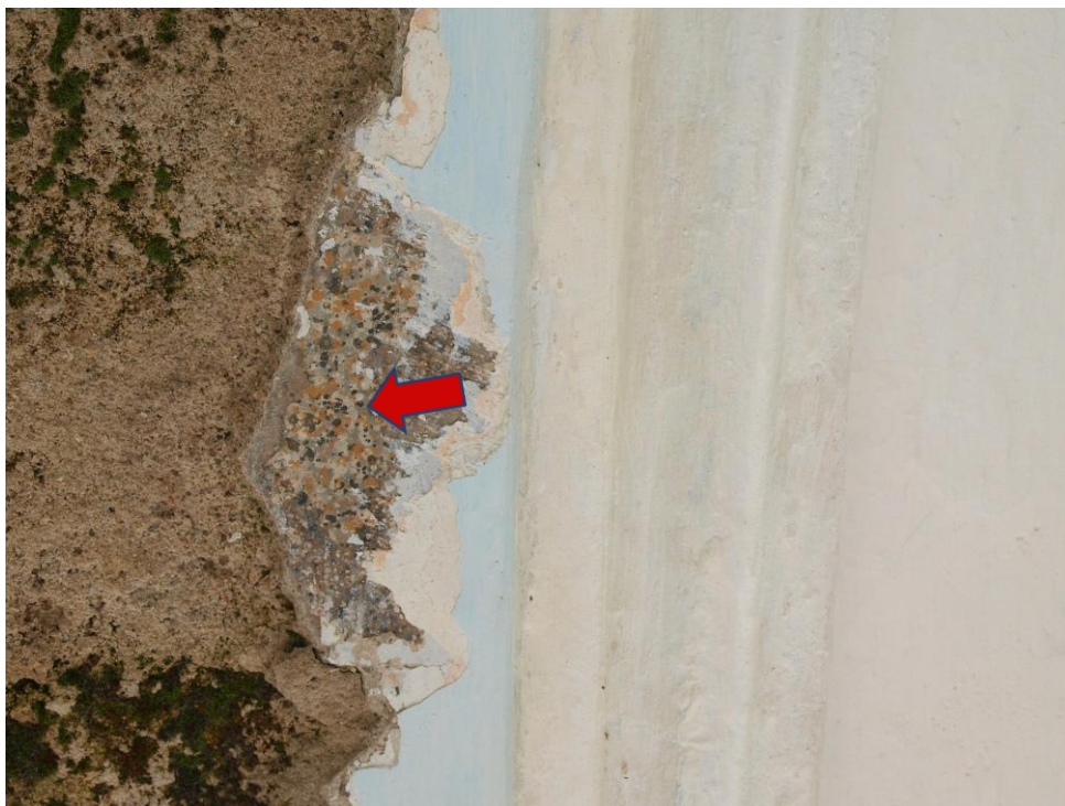
Obr. č. 112: V sondě je odkryta nejstarší barevnost kaple z roku 1898. Malba je provedená formou barevných cákanců tzv. kroupení – malířská technika imitující kámen. Použitá barevnost je v kombinaci okrové, bílé a černé. Stejné barevné řešení jako v poutní kapli Maria Rast am Stein.
