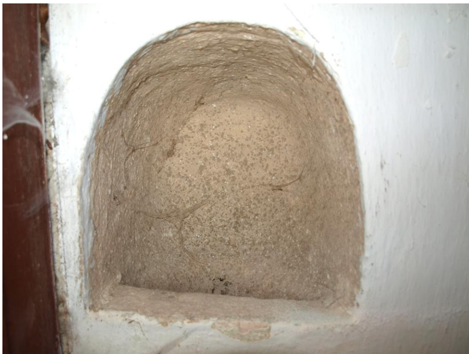
Obr. č. 98: Kropenka s dochovanou malbou tzv. kropení imitující kámen.
