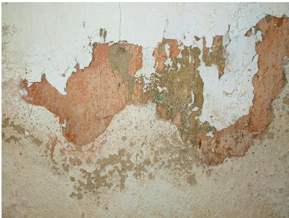
Obr. č. 32: V místech samovolných odkryvů se pod mladšími nátěry objevují historicky starší výmalby. Ve spodní části fotografie je mladší omítková vrstva lokálně použita při opravách stěn.
