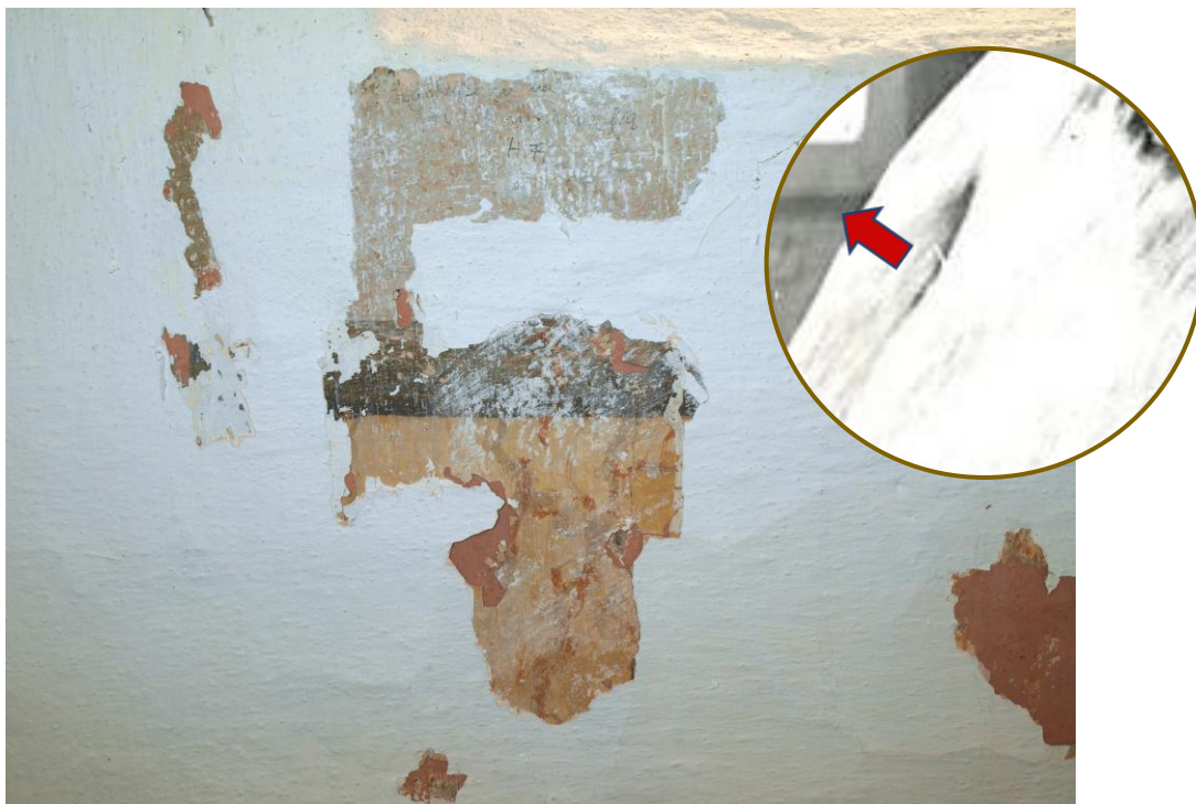
Obr. č. 70: Východní stěna kaple, sonda pod okenním parapetem s částečně odkrytou malbou soklu (barevná vrstva č. 4.). Malovaný sokl je ukončen 4 cm širokým černým pásem.
