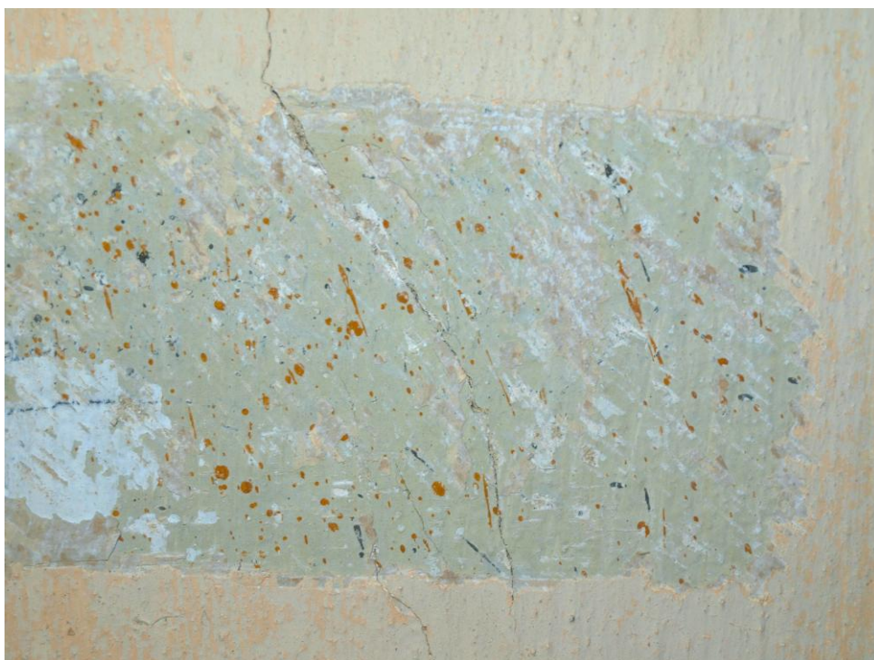
Obr. č. 83: Chodba – plocha stěny se světle zeleným nátěrem u vítězného oblouku. Kapičky na nátěru jsou způsobené při dekoraci špalety vítězného oblouku technikou tzv. kropení.
