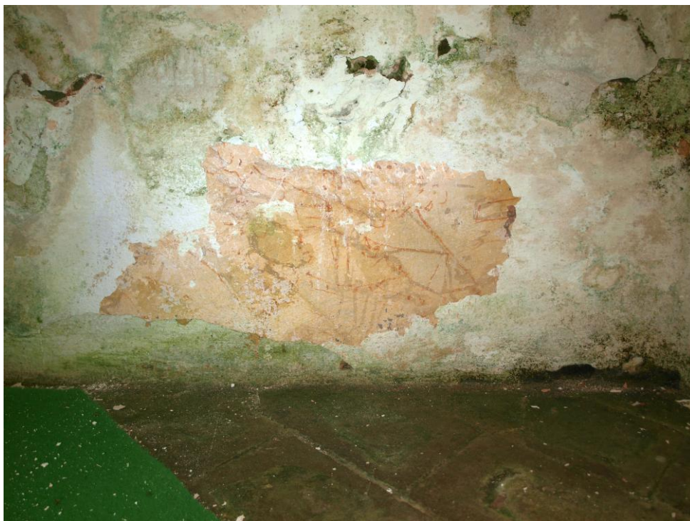
Obr. č. 74: JV stěna s částečně odkrytou malbou iluzivního mramorování.
