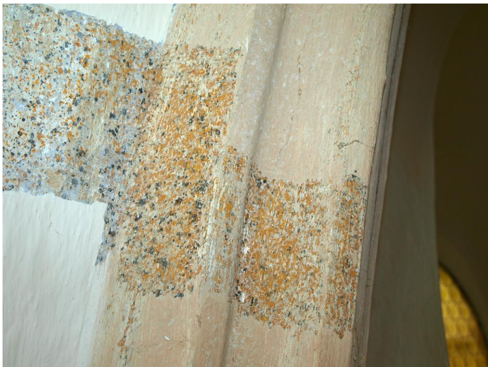
Obr. č. 37: Sonda na klenebním žebře.
