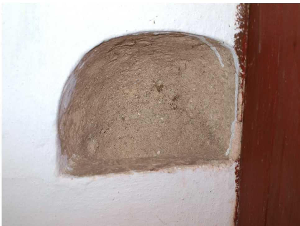
Obr. č. 93: Vnitřní část malířsky upravena imitací kamene.
