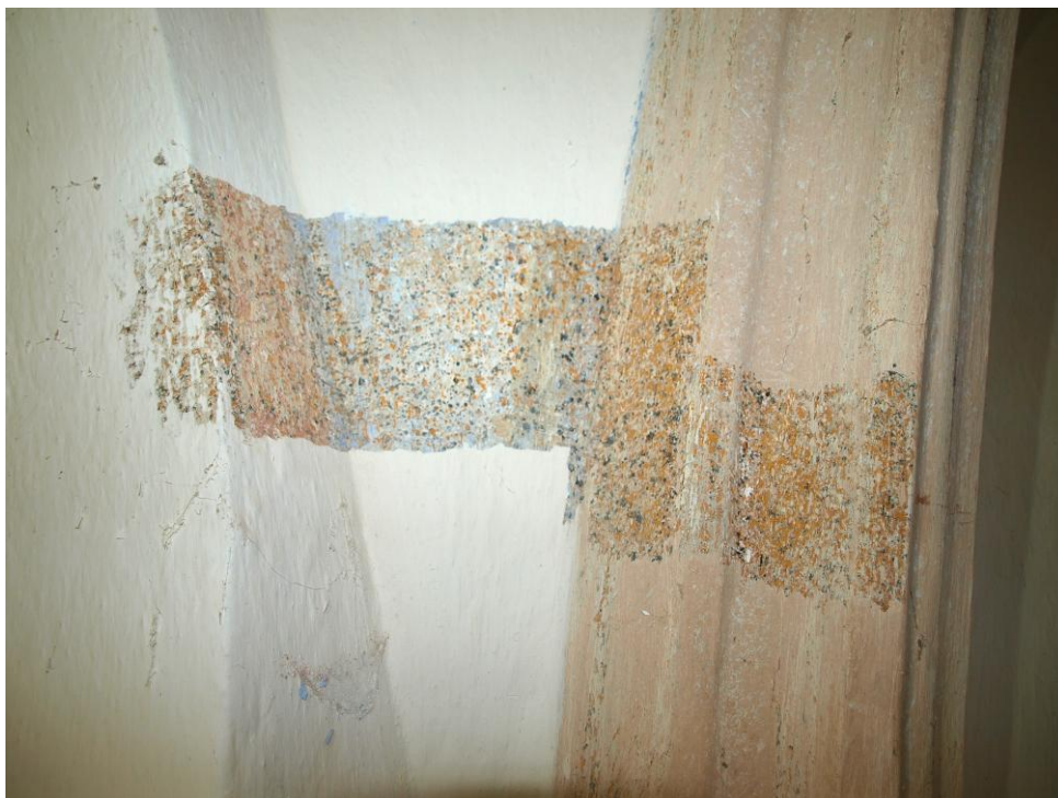
Obr. č. 38: Pásová sonda procházející přes okenní niku, klenební pole až ke klenebnímu žebří. Nejstarší barevnost kaple (barevná vrstva č. 2) imitující kámen malířskou technikou tzv. kropení.
