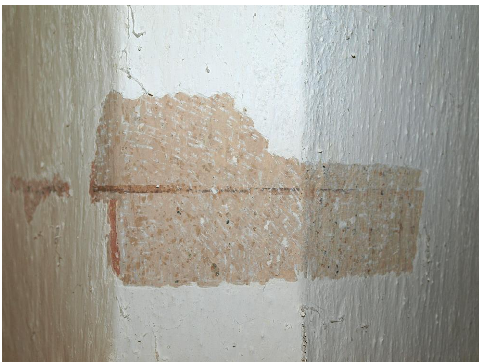
Obr. č. 63: Sonda na vítězném oblouku. Barevná vrstva č. 4. Tmavě hnědá linka předkreslená tužkou – součást malby iluzivního kvádrování.
