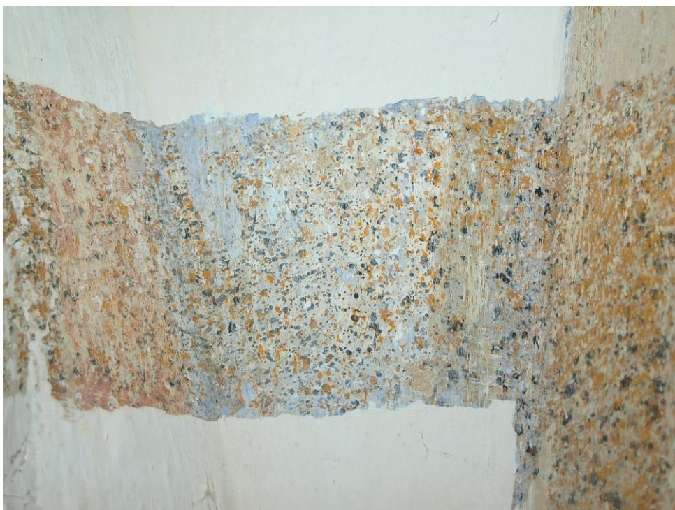
Obr. č. 39: Sonda na klenebním poli. Na klenebním poli je barevnost cákanců částečně zkreslena dvojicí mladších nátěrů v modré barvě.
