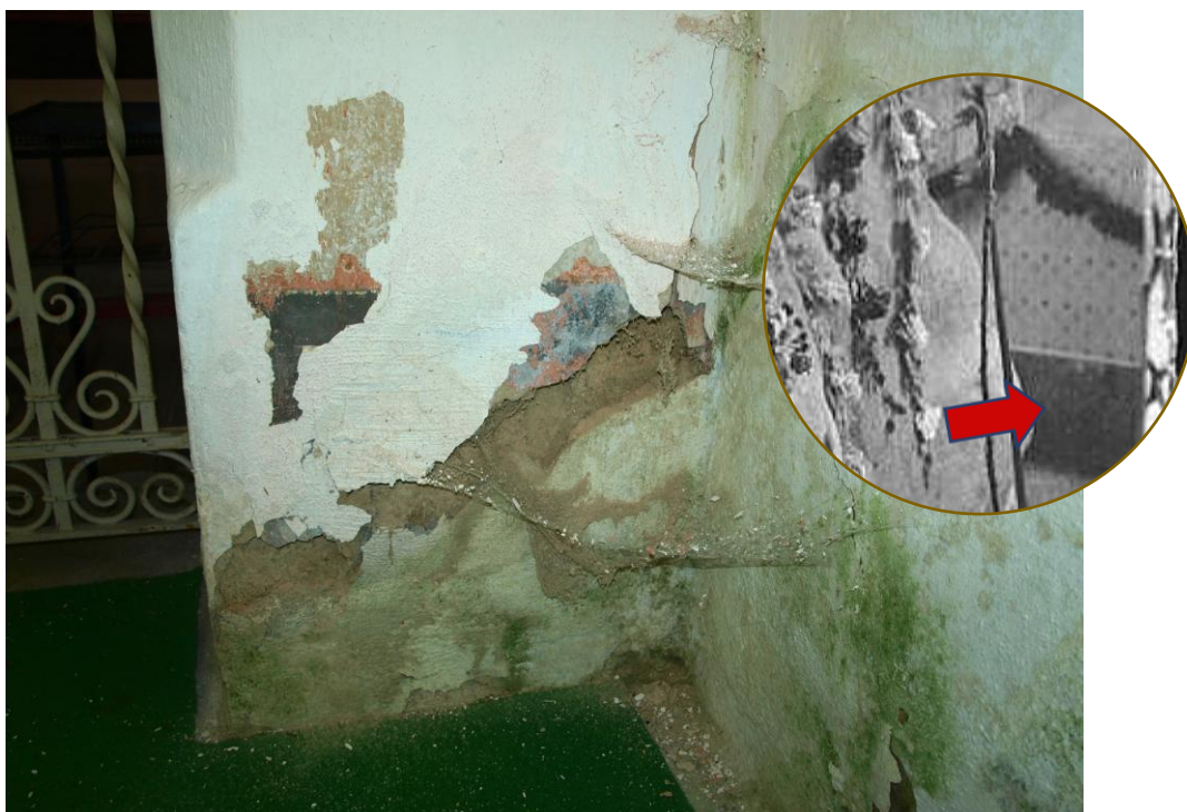
Obr. č. 52: Soklová část s tmavě šedým malovaným soklem. Barevná vrstva č. 3.
