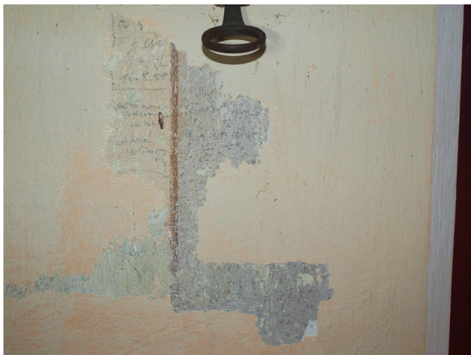
Obr. č. 89: Malba pasparty kolem vstupního otvoru provedená formou barevných cákanců imitující kámen. Paspartu lemuje hnědá linka.
