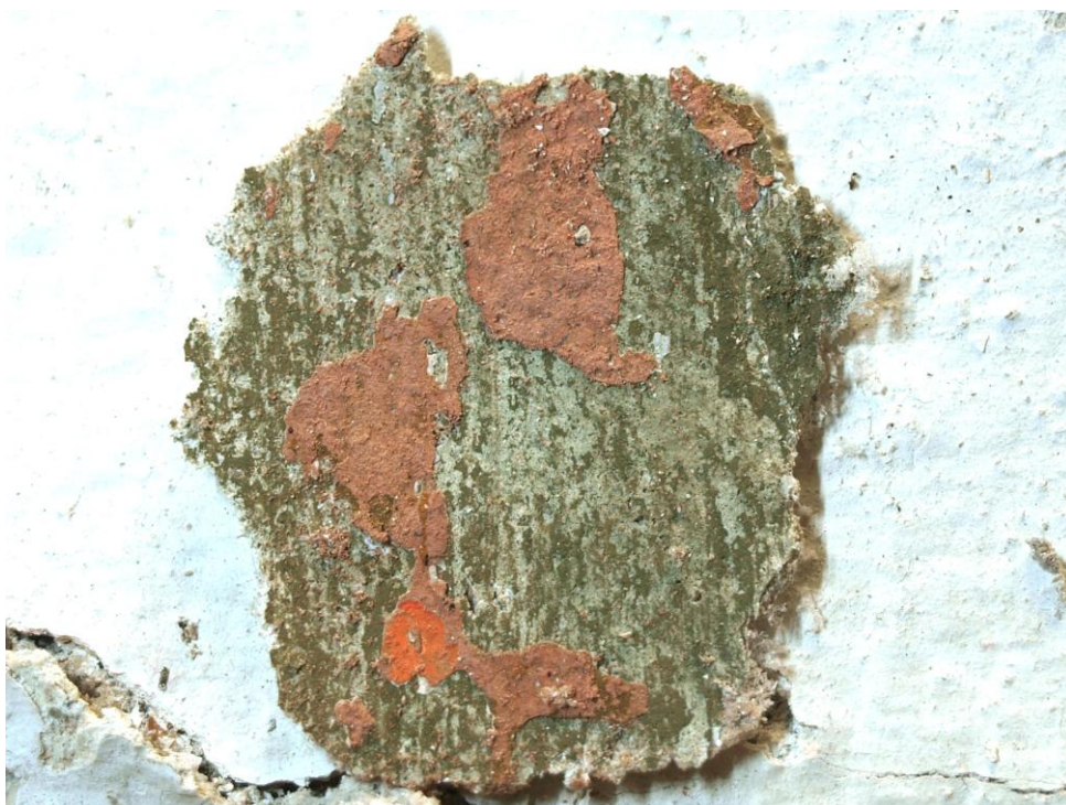
Obr. č. 69: Detail barevných vrstev č. 3 – růžová a č. 4 – monochromní zelená.
