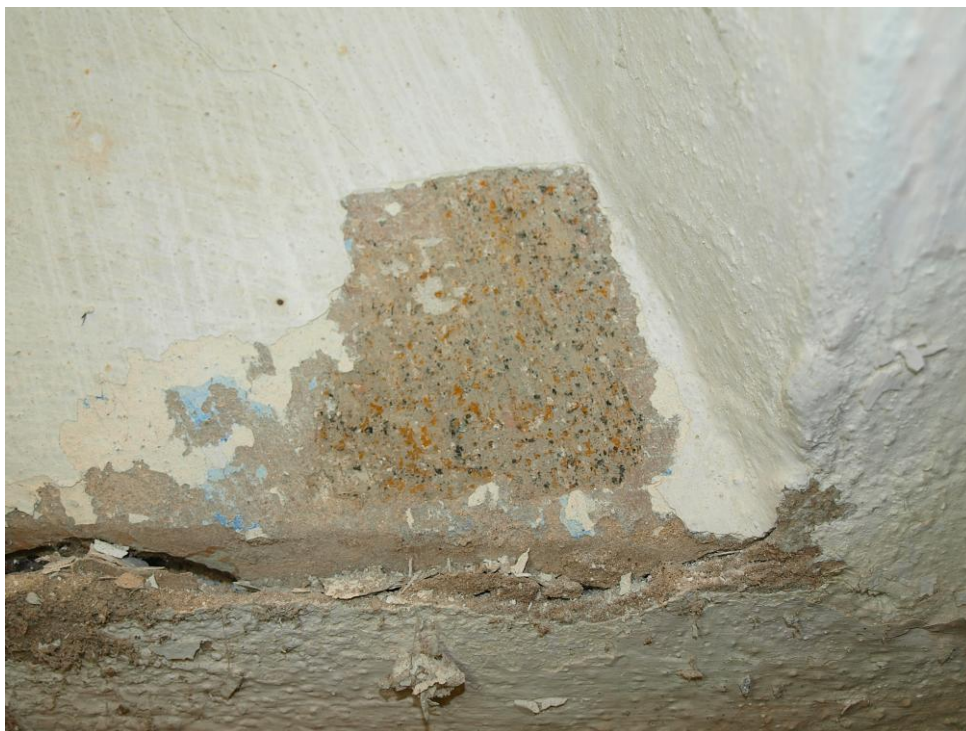
Obr. č. 42: Parapet okenní niky. V sondě je odkrytá nejstarší barevnost kaple.
