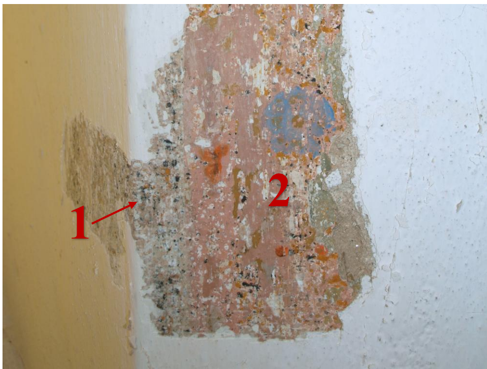
Obr. č. 45: Sonda u okenní špalety. 1 – nejstarší barevnost kaple z roku 1890, tzv. kropení imitující kámen, 2 – na růžovém podkladě dekorativní malba květů (barevná vrstva č. 3).
