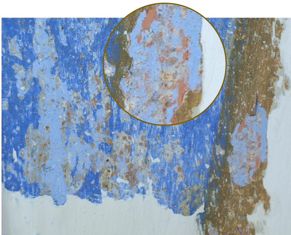
Obr. č. 51: Sonda na klenebním poli. Malba květů na růžovém podkladě byla doplněná na klenebních polích bleděmodrým monochromním nátěrem s drobnými hvězdami.
