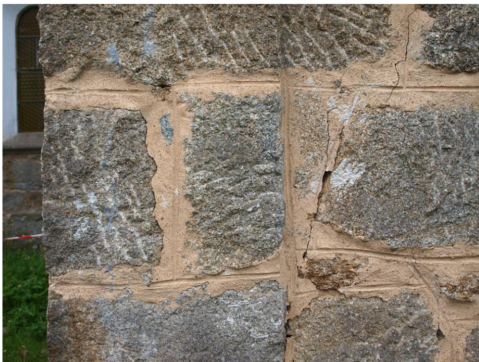
Obr. č. 100: Exteriérová část. Původní historické spárování kamenného zdiva.
