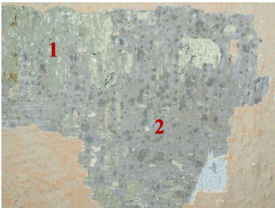
Obr. č. 90: Detail. 1 – nejstarší monochromní barevnost, 2 – malovaná pasparta imitující kámen (malba tzv. kropením)
