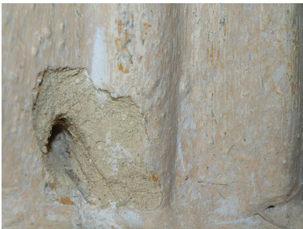
Obr. č. 61: Žebra klenby jsou z vápenné malty.
