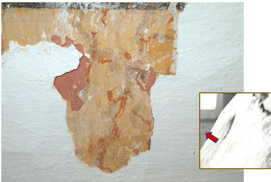
Obr. č. 73: V sondě je odkrytá malba iluzivního mramorování zdobící soklovou část stěn.
