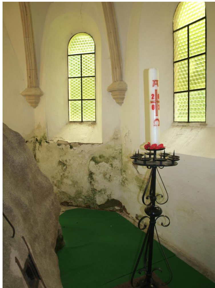
Obr. č. 12 a 13: Poškození omítek do výšky okenních parapetů.
