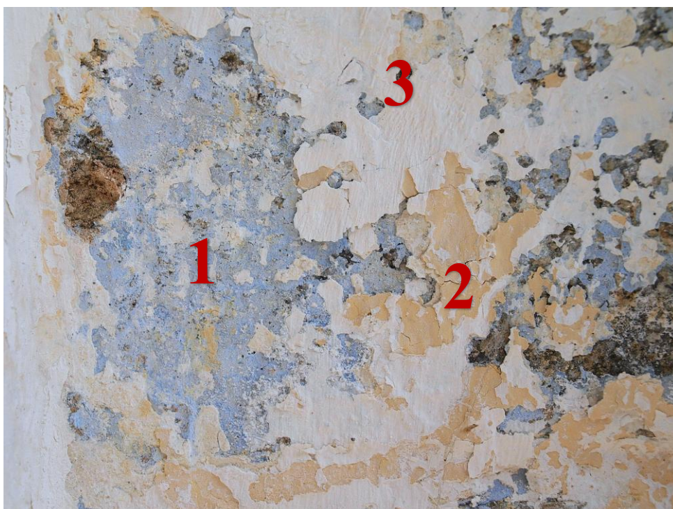
Obr. č. 115: Detail. 1 – monochromní nátěr v modré barvě, 2 – mladší okrový nátěr, 3 – tenké souvrství nejmladších bílých nátěrů
