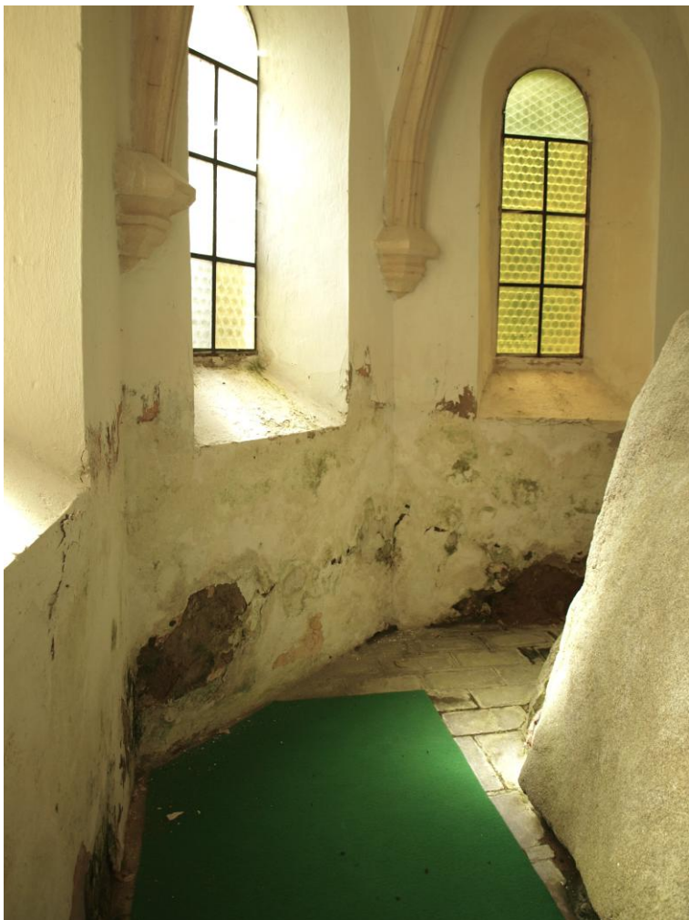
Obr. č. 12 a 13: Poškození omítek do výšky okenních parapetů.
