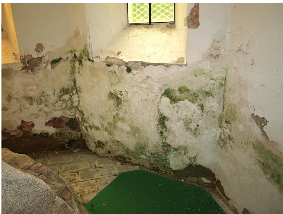
Obr. č. 17: JZ stěna polygonálního uzávěru kaple pokrytá zeleným organickým povlakem.
