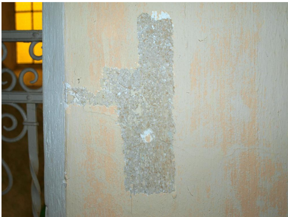
Obr. č. 86: Čelní stěna vítězného oblouku. V sondě je odkryta malba provedená formou barevných cákanců imitující kámen.
