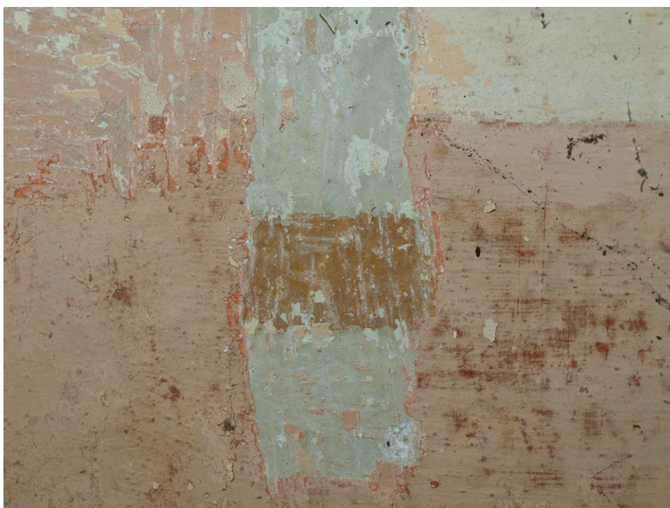
Obr. č. 85: Ve výšce kolem 77 cm je namalován jednoduchý sokl v podobě okrového pásu širokého 2,5 cm.
