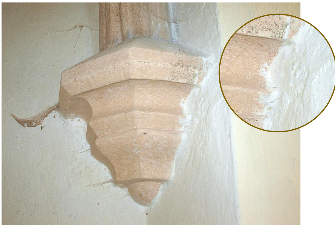
Obr. č. 78: V novodobé historii kaple byly plochy stěn přetírané častěji než plastické prvky klenby. Historicky starší barevná úprava žeber s iluzivním spárováním nebyla zabílena.
