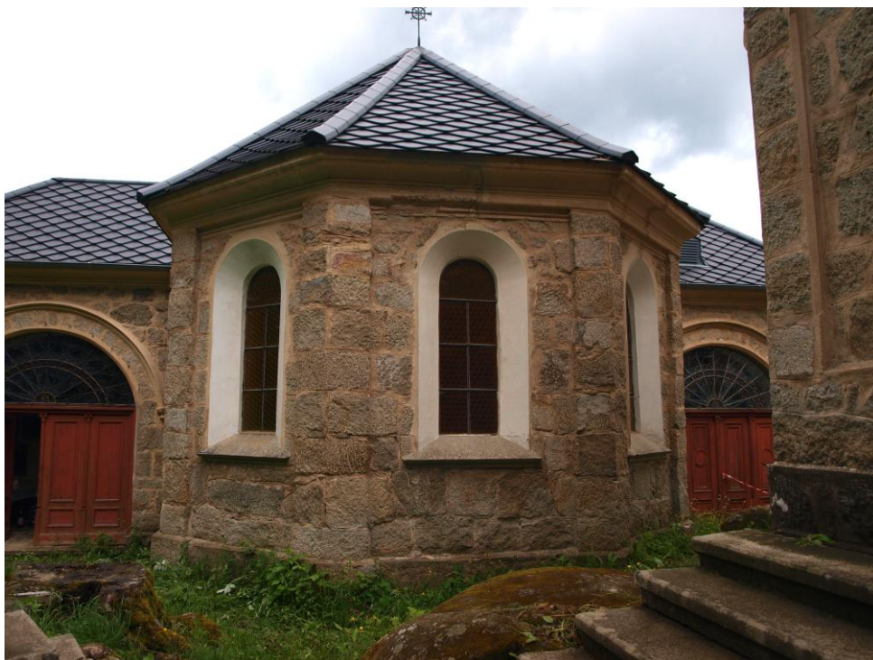
Obr. č. 8: Poutní kaple od jihu. Dvojice rozměrných dveří zajišťovala plynulý pohyb poutníků.
