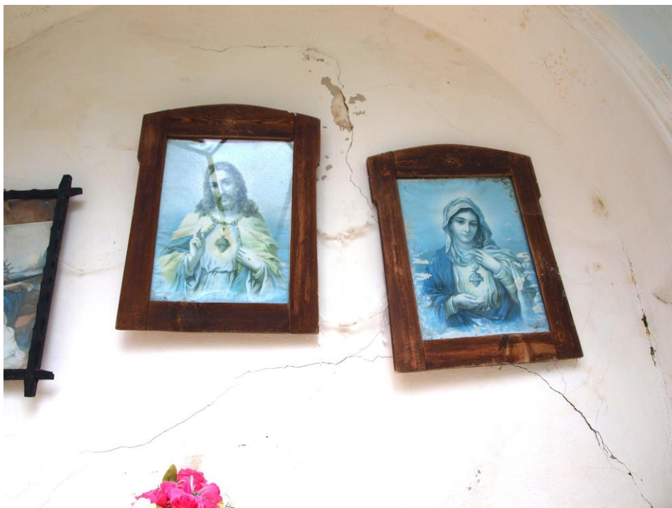
Obr. č. 116: Čelní stěna kaple Božího hrobu. Omítková vrstva je odtržena od podkladu s viditelnou sítí trhlin.
