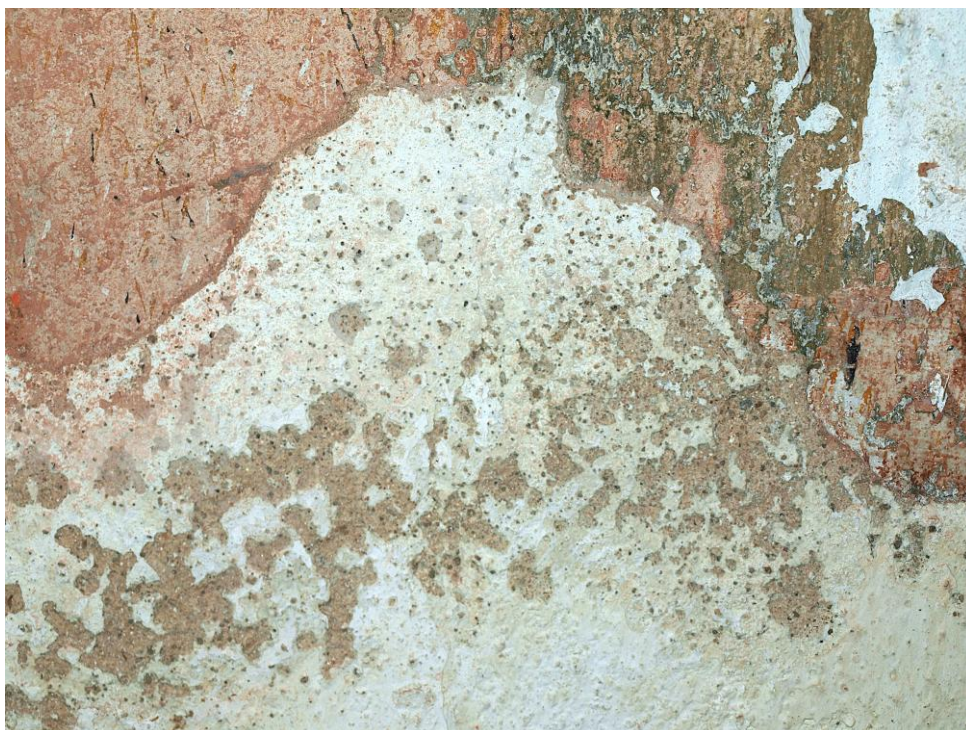
Obr. č. 33: Detail mladší omítkové vrstvy použité během oprav kaple v roce 1972.
