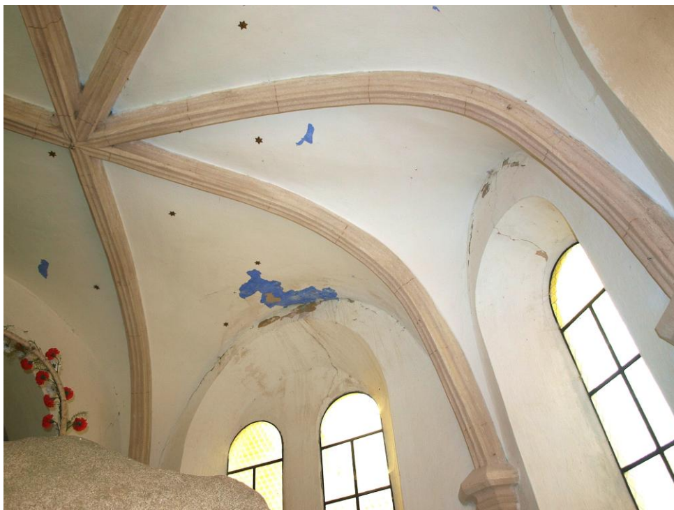
Obr. č. 54: Celkový pohled na klenbu kaple.
