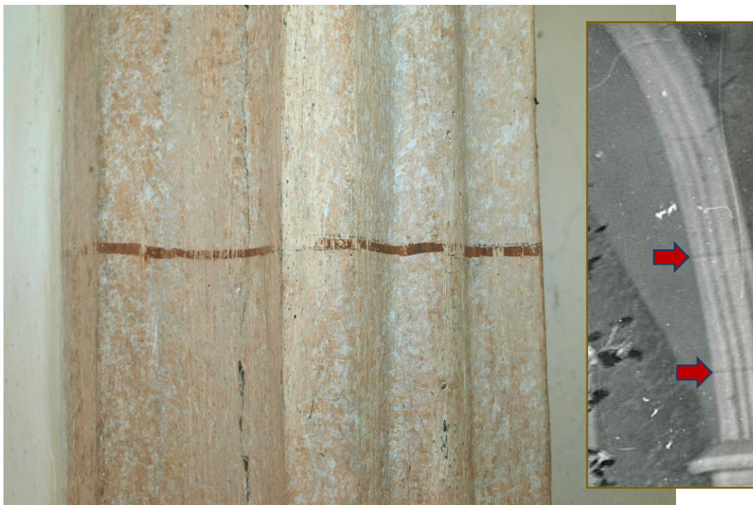
Obr. č. 60: Iluzivně malovaná spára v hnědé barvě. Barevná vrstva č. 4.
