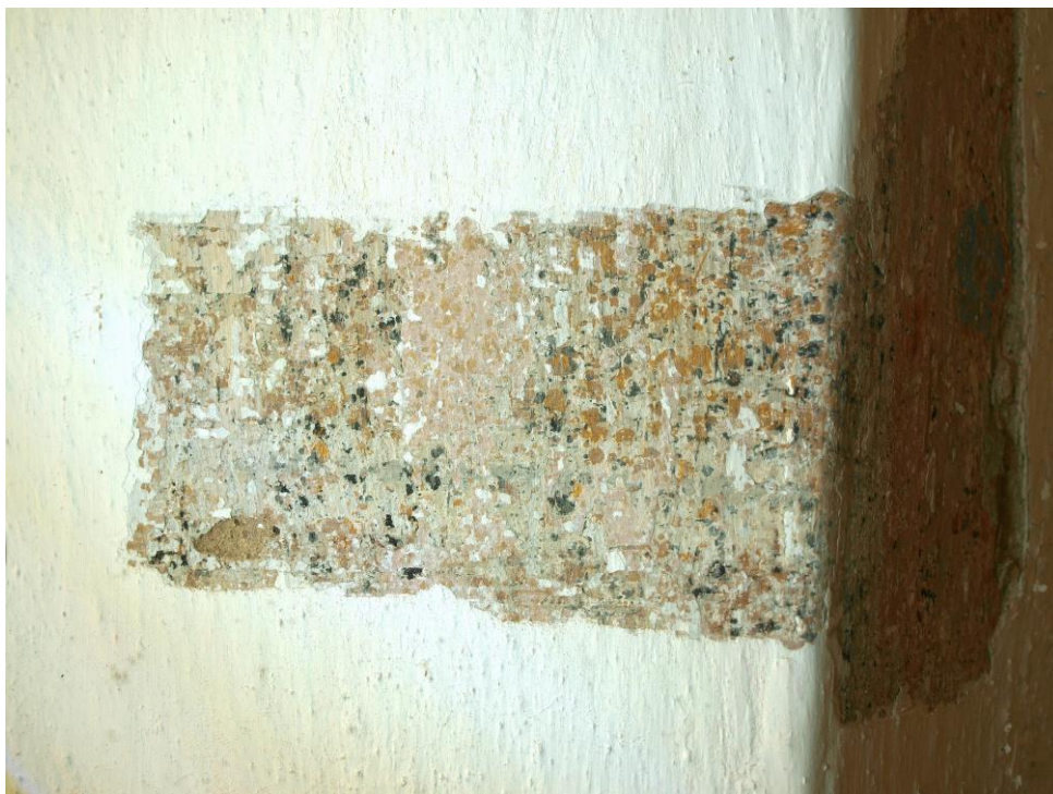
Obr. č. 49: Sonda ve špaletě okna. Fragment iluzivně malované spáry v bílé barvě.
