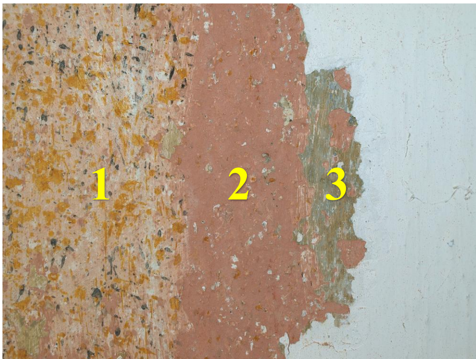
Obr. č. 68: Detail souvrství. 1 – nejstarší barevnost kaple (barevná vrstva č. 2) imitující kámen malířskou technikou tzv. kropení, 2 – dekorativní malba květin na růžovém podkladě (barevná vrstva č. 3), 3 – monochromní nátěr v zelené barvě (barevná vrstva č. 4)
