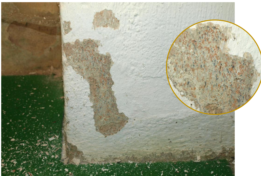
Obr. č. 43: Sonda provedená v soklové části vítězného oblouku – západní stěna. Celoplošná malba cákanců bez soklu. Nejstarší dekorativní malba.
