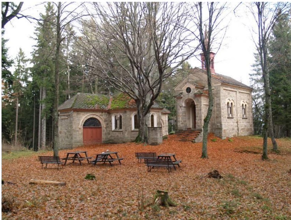
Obr. č. 3: Celkový pohled od jihozápadu na poutní místo Maria Rast nad Vyšším Brodem.
