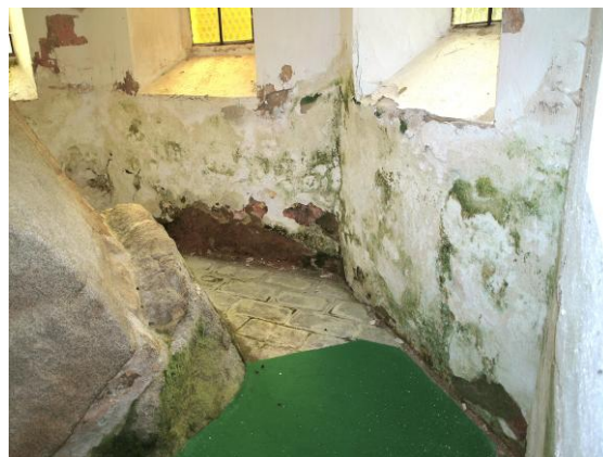
Poškození omítek v soklové části poutní kaple Maria Rast am Stein.
