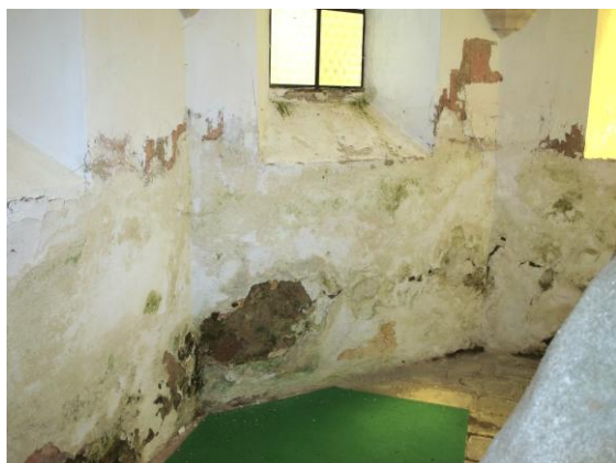
Poškození omítek v soklové části poutní kaple Maria Rast am Stein.
